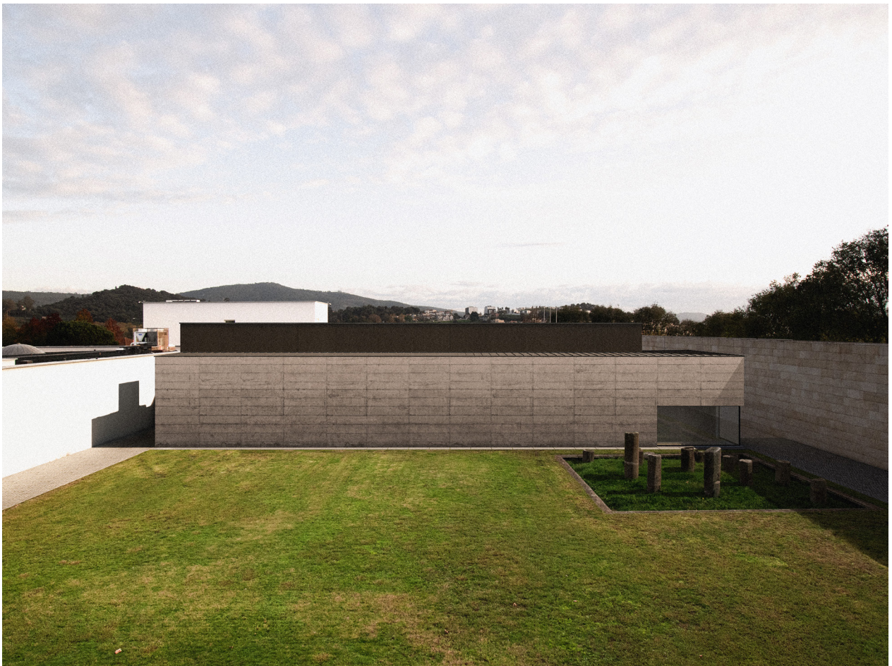
Pavilhão Museu de Arqueologia D. Diogo de Sousa João Mendes Ribeiro Arquitecto
